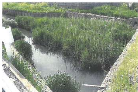
加須市水深地内江川堀浚渫工事 着手前
