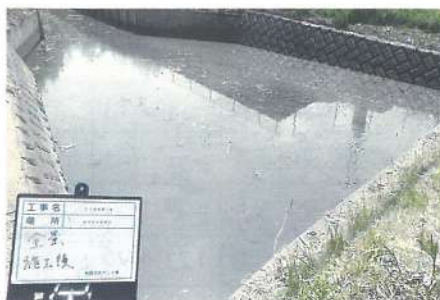
江川堀浚渫工事 施工後
